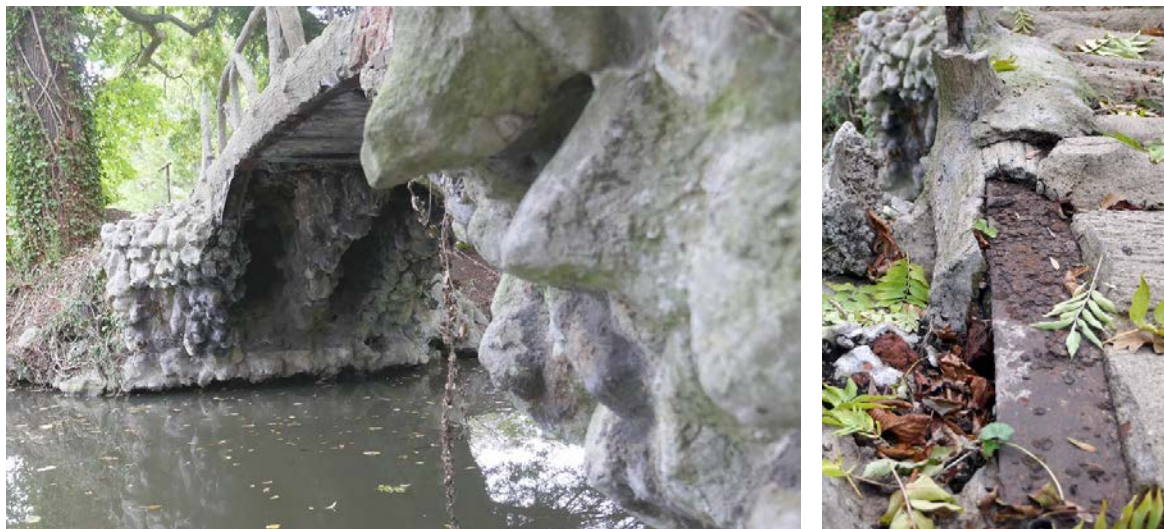
Afb. Brug op landgoed Villa Kanjel in Maastricht, roestende wapening vormt een uitdaging (foto: Michiel van Hunen)
